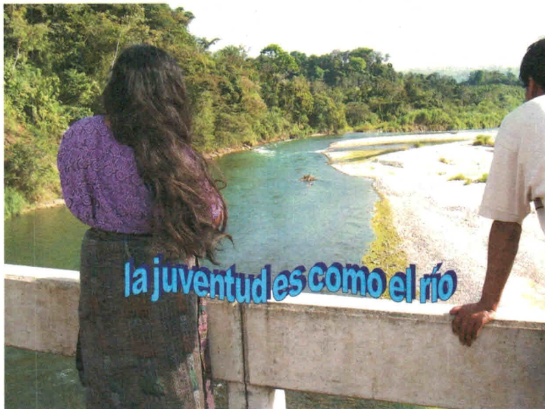
Puente sobre el río Ixcán
